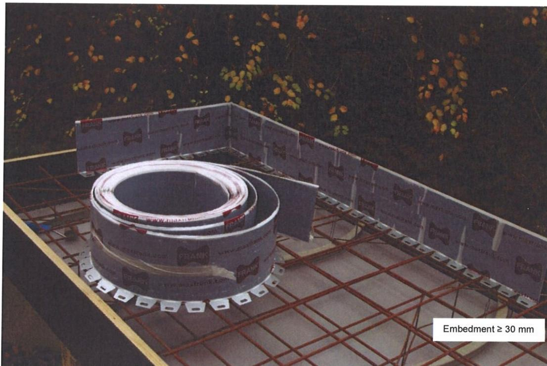
Tôle d'étanchéité revêtue "Fradiflex Premium avec angle de montage" - deux côtés revêtus
