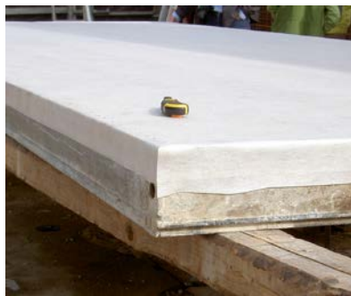
Max Frank Schalungsbahn selbstklebend auf der Schalung montiert
