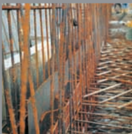
passaggio lamiera per giunti pavimentazione/parete
