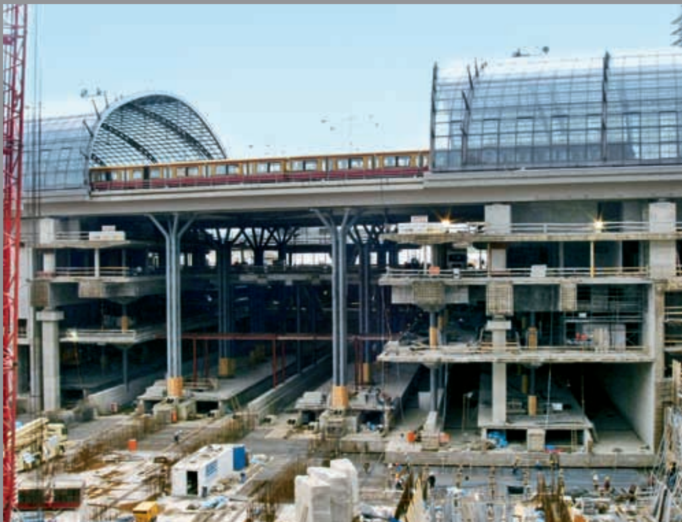
panoramica cantiere stazione „Lehrter Bahnhof“, Berlino
