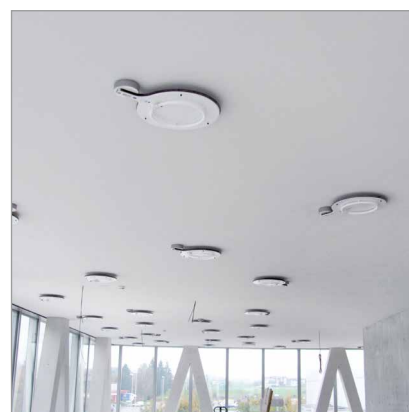
Oberflächenoptik mit Akustikspachtel
