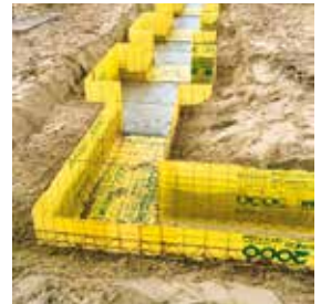
Strokenfundering aangevuld of verdiept
